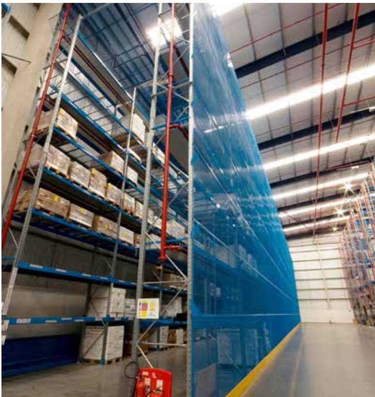
Axellent SafeStore skridsikring leveret med specialkonsoller i kundespecifik farve for at passe til kundens øvrige anlæg.
