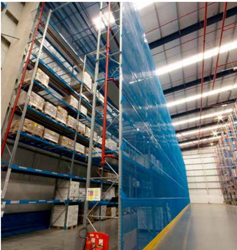
Axelent SafeStore skridsikring leveret med specialkonsoller i kundespecifik farve for at passe til kundens øvrige anlæg.
